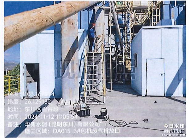
DA015 3#包机除尘器排放口 (FQ10#)
