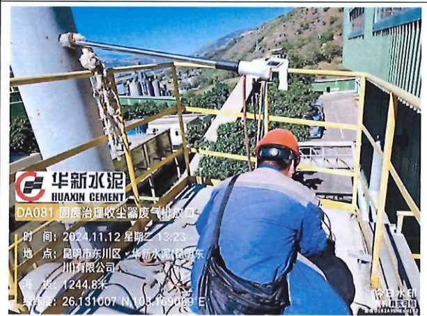
DA081 固废治理收尘除尘器排放口 (FQ14#)
